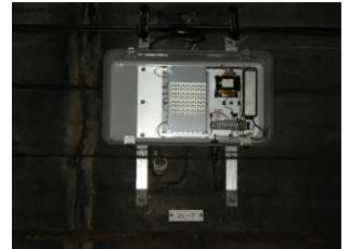
LED照明器具(取替後)
