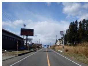
上片貝 道路情報板(取替後)
