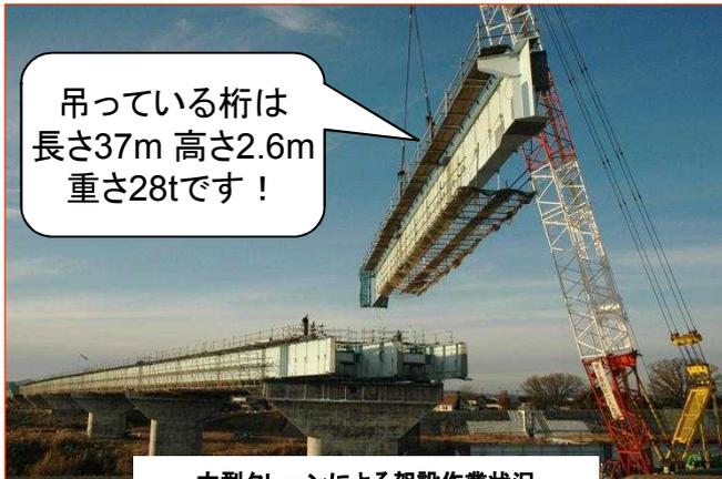
大型クレーンによる架設作業状況
