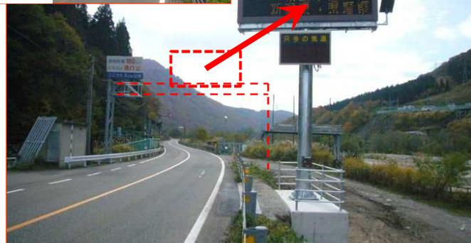
三俣情報板(柱形状の変更で、車道への落雪を低減)
