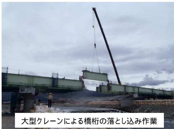
大型クレーンによる橋桁の落とし込み作業
