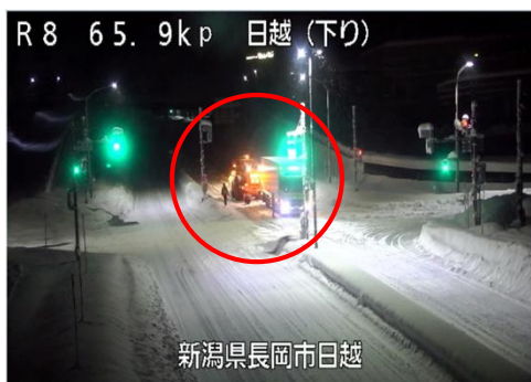
R8.1.24 国道8号 (長岡市日越地先)
