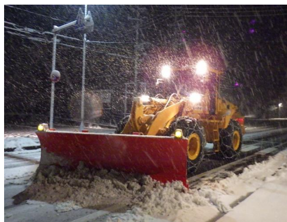
湯沢町三国地先 除雪ドーザ
