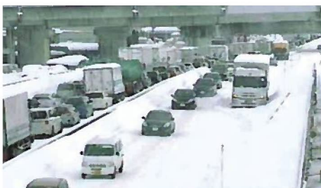
H28.1新潟県中越地域に寒波襲来（長岡市新組跨線橋）
