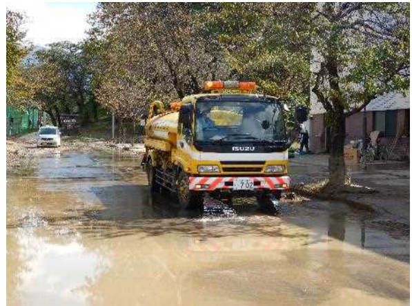
被災地での作業状況【路面清掃】
