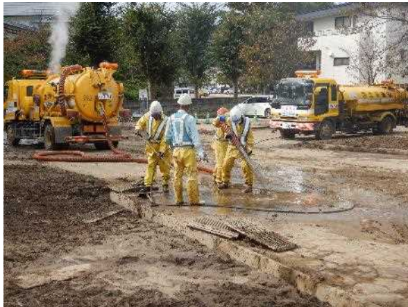
被災地での作業状況【側溝清掃】
