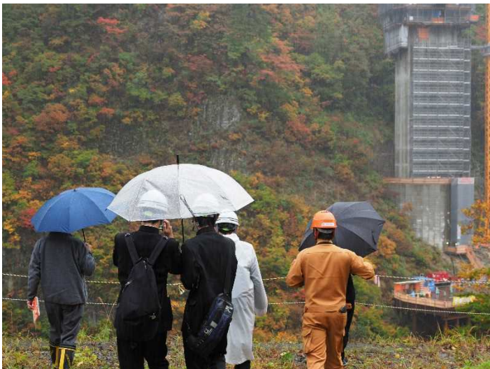
5号橋梁を撮影
