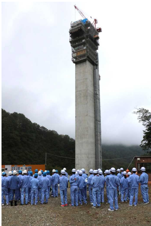
5号橋梁の施工方法に関する説明
