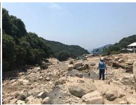
【土石流による土砂堆積】
