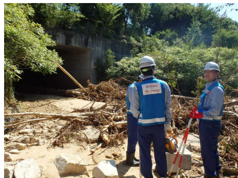
【土石流による土砂堆積】
