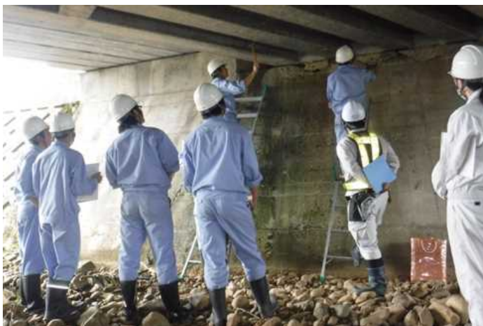
打音検査で浮きの有無を確認
