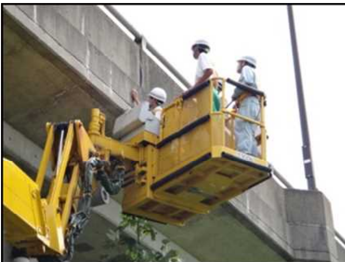
国道17号十日町高架橋(下り)の橋梁点検作業を体験
