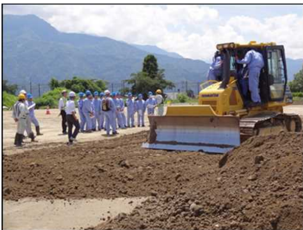
ブルドーザーに乗り込みICT機器について説明
