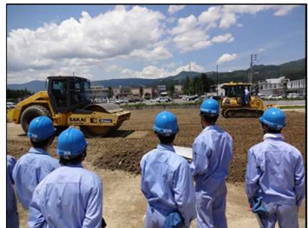
転圧機械に乗り込み、実際のICT土工を体験
