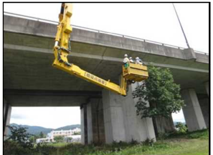
国道17号十日町高架橋(下り)の橋梁点検作業を体験
