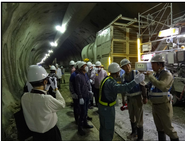
1号トンネル 内部にて工法・施工機械等の説明
