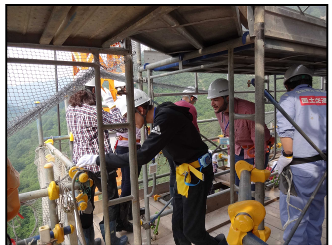
5号橋梁 地上70mの高さにびっくり!
