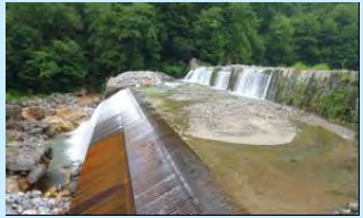
よせざわ 大町市土地改良区 寄沢頭首工
