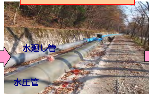
水圧管を敷設して・・・
