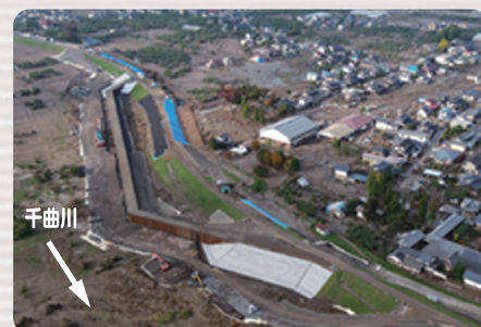
令和元年（2019）10.30 応急復旧完了時
