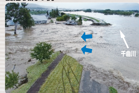
令和元年（2019）東日本台風における堤防の決壊状況
