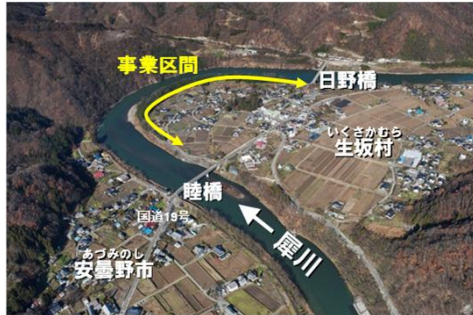
下生野地区堤防整備事業
