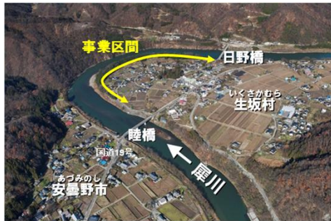
下生野地区堤防整備事業
