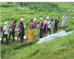
平成18年7月洪水 飯山市常盤での漏水対応 (月の輪工法)
