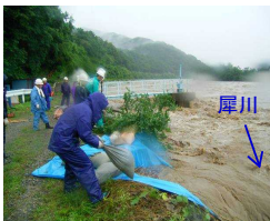
平成18年7月洪水 生坂村小立野での水防対応 (土のう積み)
