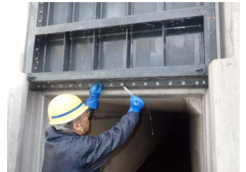
樋門ゲート点検
