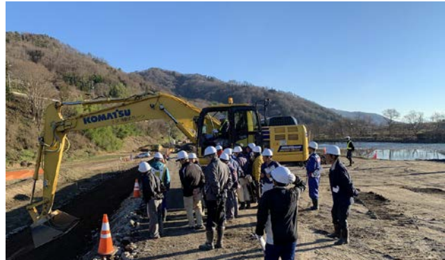
【小立野築堤工事現場見学会】
