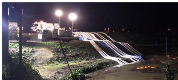
平成29年10月台風21号出水 飯山市内の今井川樋管へ排水ポンプ車を派遣
