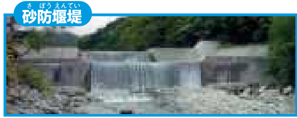
山崩れによる土砂をためて、下流へ流れないようにしています。
