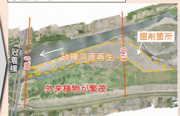
② 整備直後 (平成27年7月)
