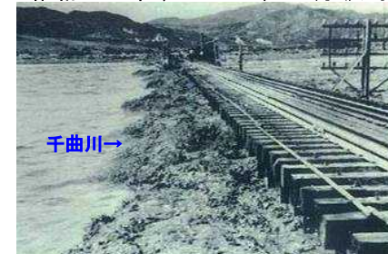
千曲川出水状況(信越線篠ノ井鉄橋)
