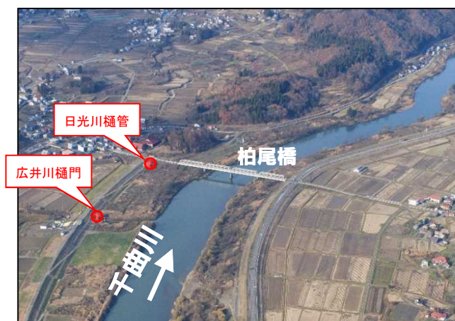
日光川樋管 全景
