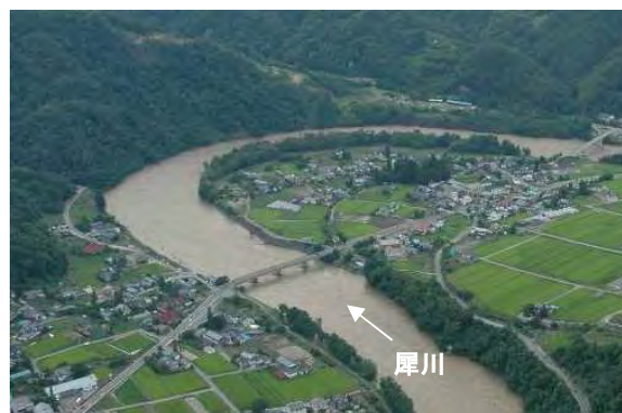
平成18年7月出水時の状況
