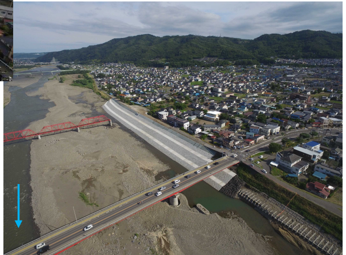
堤防及び護岸復旧完了→ (R2.6.20撮影)
