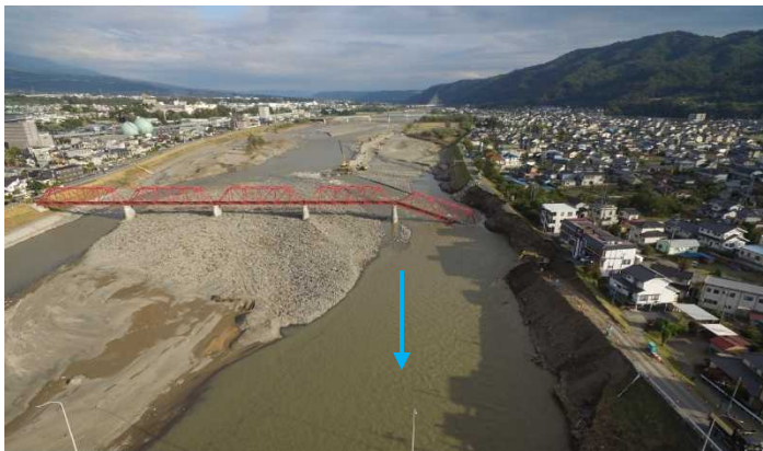
↑ 被災状況 (撮影 R元.10.14)
