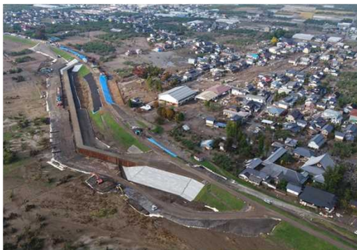
↑仮締切堤 (R元.10.30)
