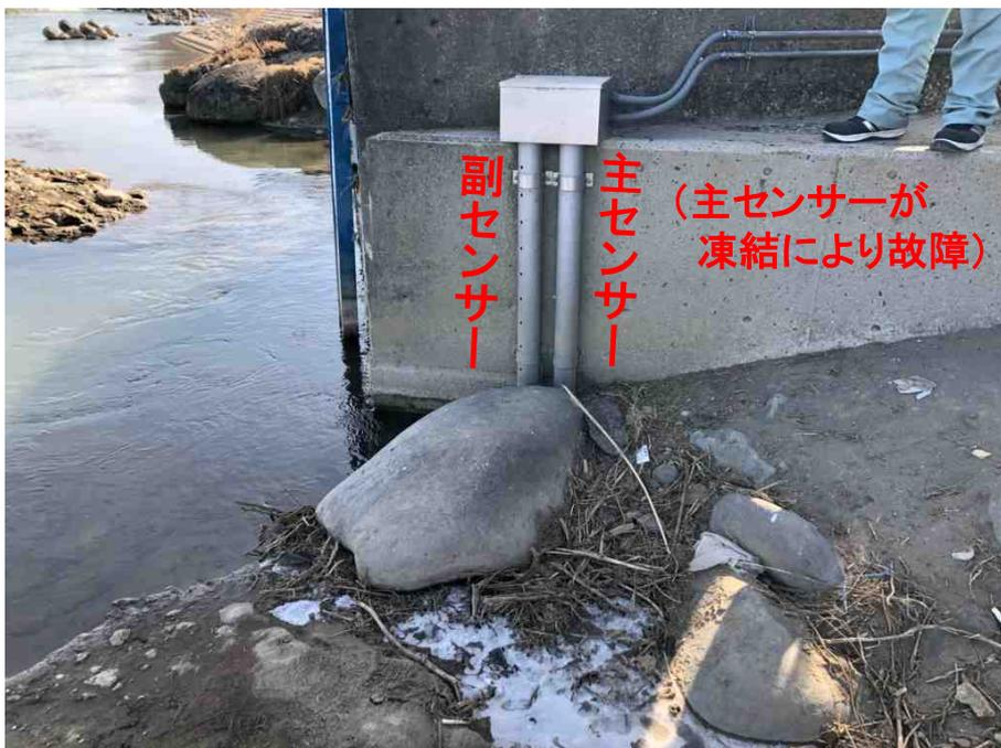
水位計センサー(水圧式)が凍結により異常な圧力を感知し異常値を観測した。
