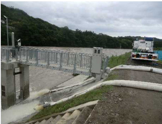
排水ポンプ車稼働状況: 生坂村 おだての小立野地先 (7月8日14時20分頃)
