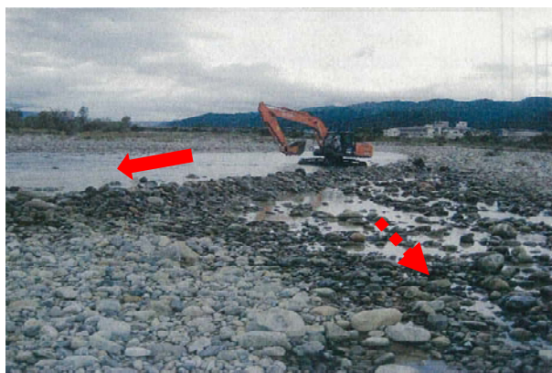
【大町建設事務所による高瀬川の河道整正作業状況（水筋の安定化）】
