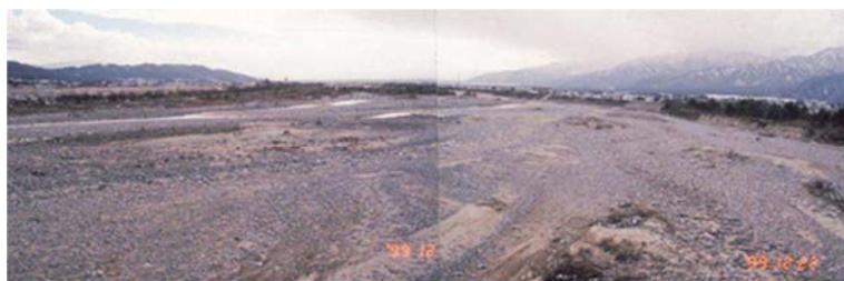
【平成 11.12.22 高瀬上橋下流の高瀬川の状況】
