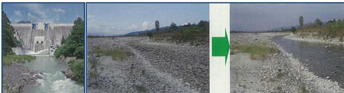
【放流する大町ダム】 【高瀬川瀬切れ状況（平 21.9.26）（左）と放流による瀬切れ解消状況（平 21.9.27）（右）】
