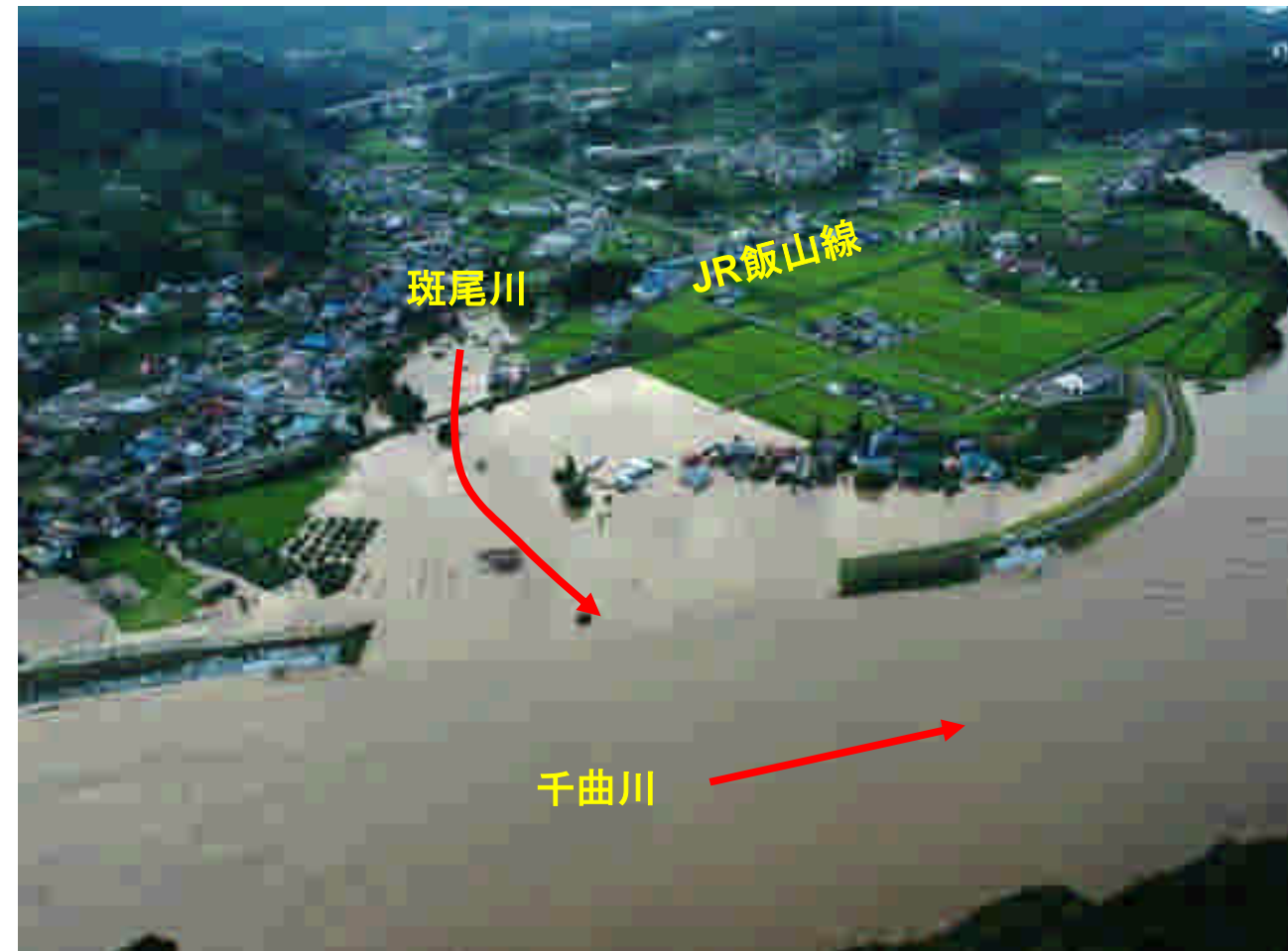
堤防整備中の中野市替佐地区 浸水状況 (H18年7月)
