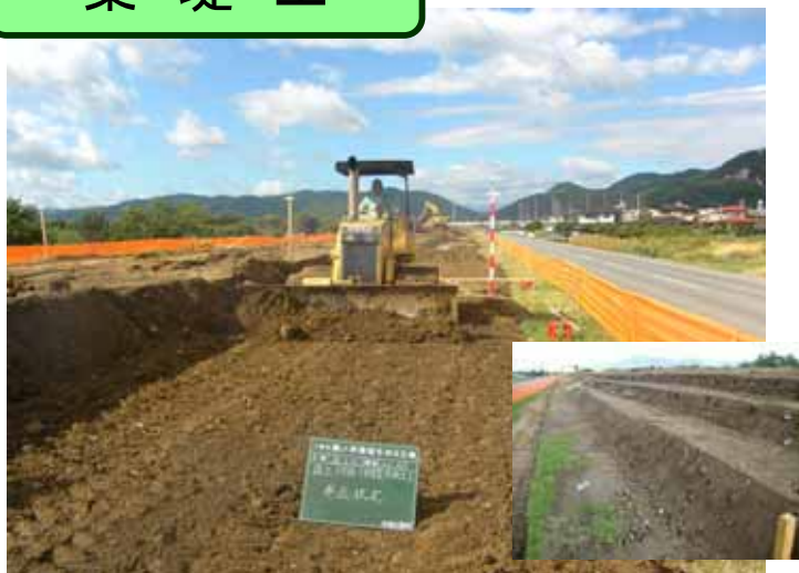
敷き均し状況（既設堤防の段切り）
