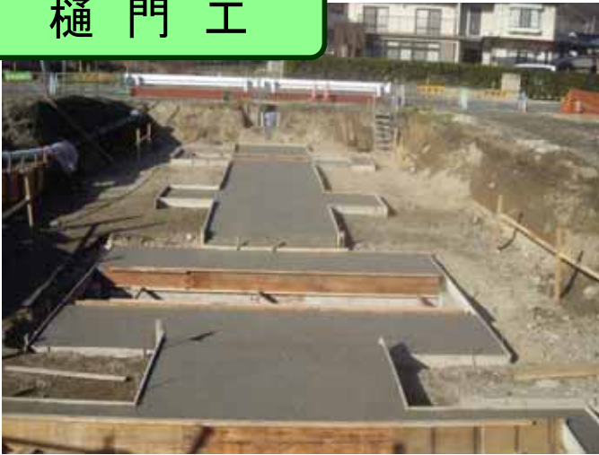
均しコンクリート
