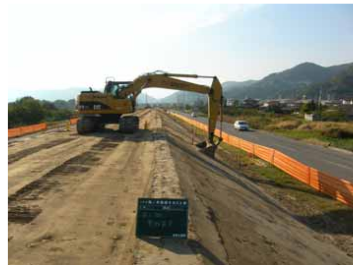
法面整形状況
