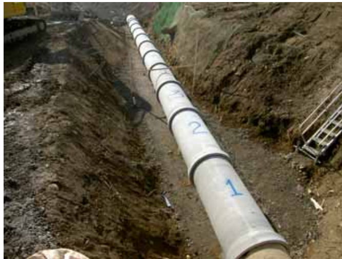
上水道取水管の付け替え
