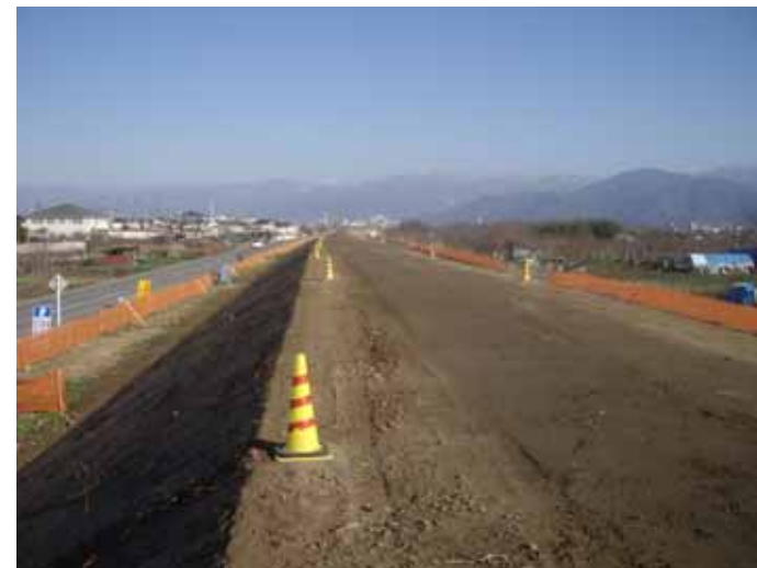
築堤整備状況
