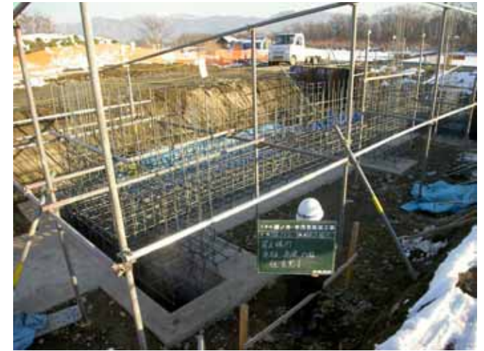
樋門BOXの配筋
