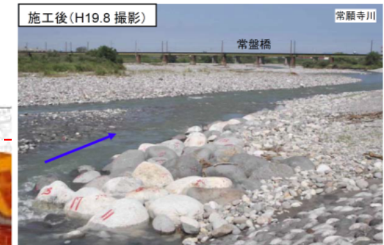
施工後の様子
