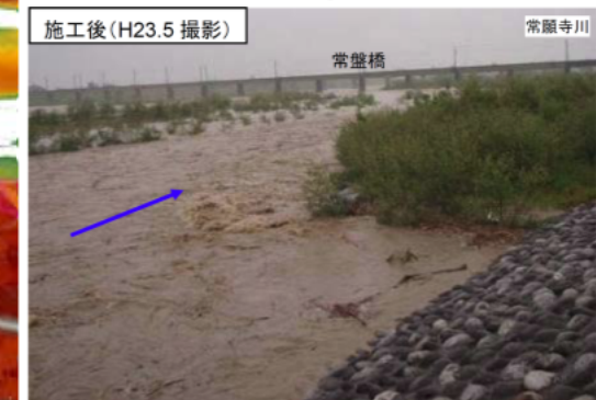
洪水の主流を河岸際から離している
