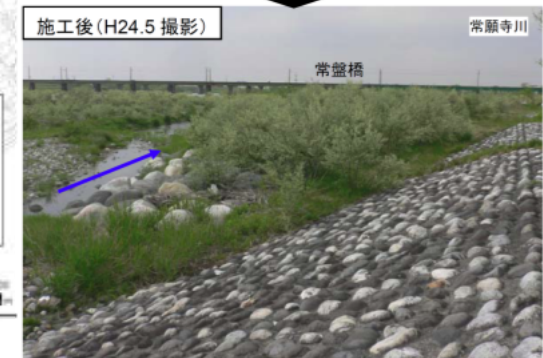
施工後5年経過し、植生の繁茂が確認された
