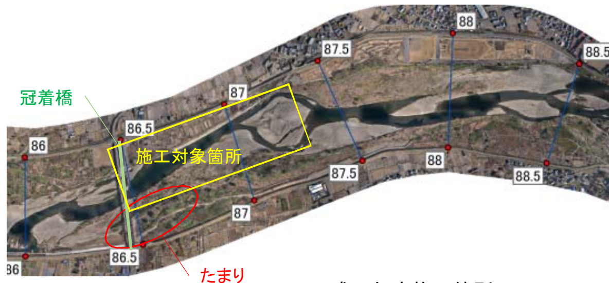
平成26年度施工箇所
