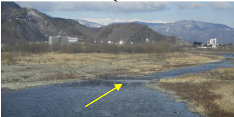
維持対応による樹木伐採
