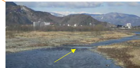
維持対応による樹木伐採
