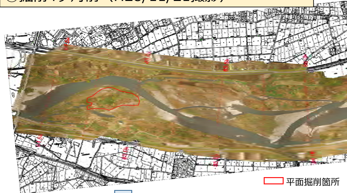
① 掘削4ヶ月前 (H28/11/21撮影)
