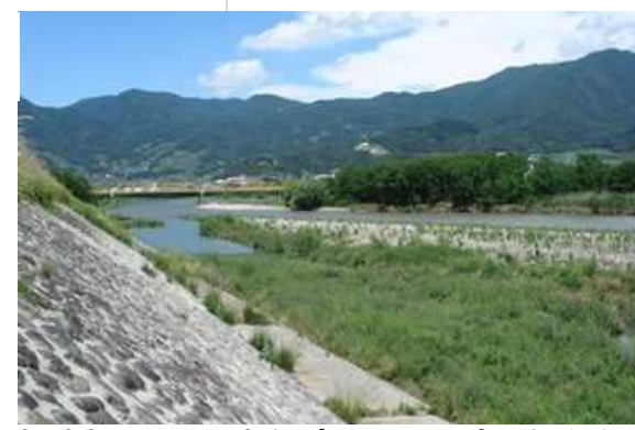
坂城町大望橋（95.0kp）付近
