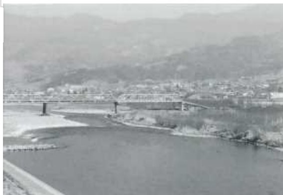
坂城町大望橋（95.0kp）付近
