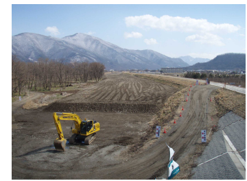
左岸側土砂の仮置き場
