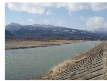
右岸側施工箇所の河道
