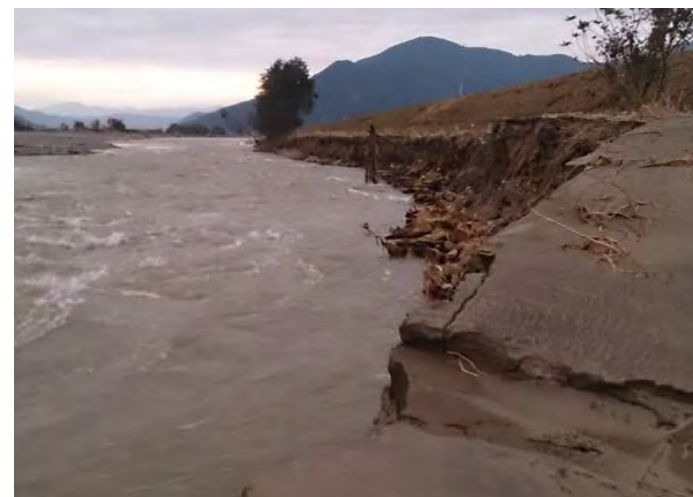
令和元年度洪水 南条地区右岸付近護岸欠損
