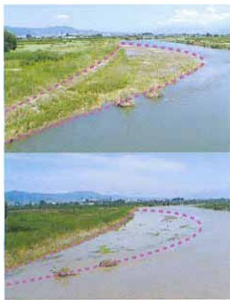
点線の範囲が、河岸を掘削して、水に浸かりやすくした場所です。普段の水位だと、水に浸かりません。
