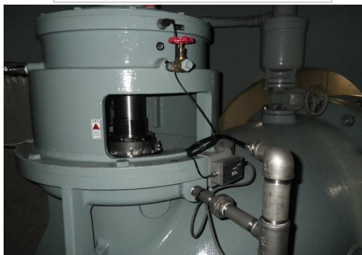
1号主ポンプ設備据付状況
