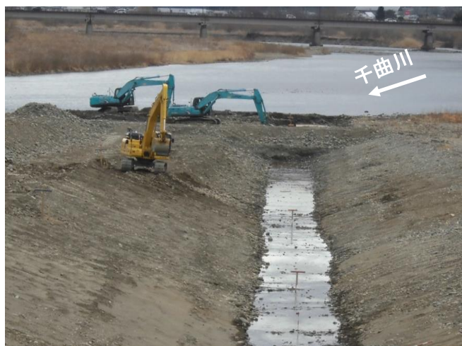
大正橋(左岸) 河道掘削状況
