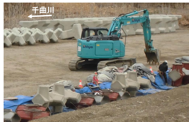
冠着橋(左岸) 根固めブロック製作状況
