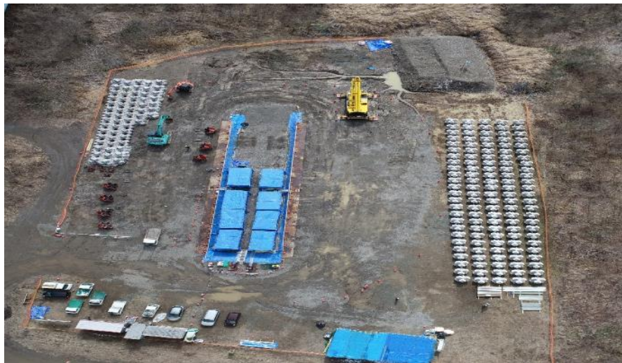
根固めブロック製作
