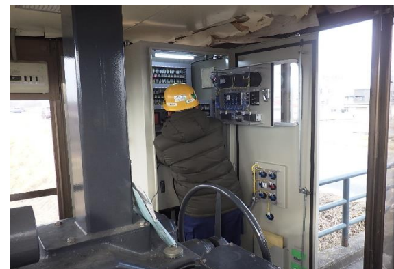
操作盤設置接続
