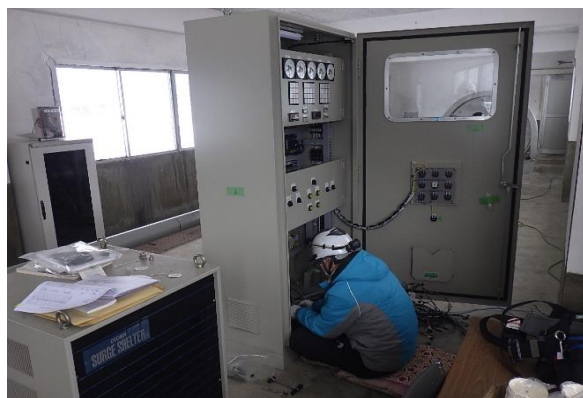
操作盤設置接続
