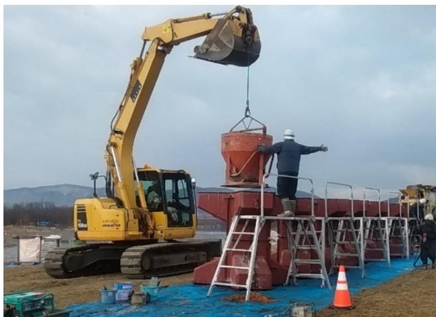
根固めブロック(5t) 製作状況
