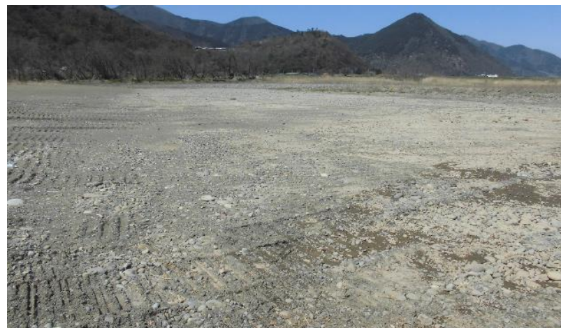
河道掘削 完成状況
