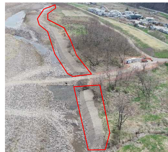
腹付盛土 完了
