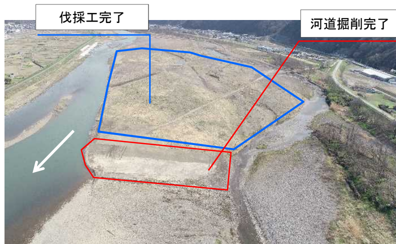
伐採工、河道掘削 完了
