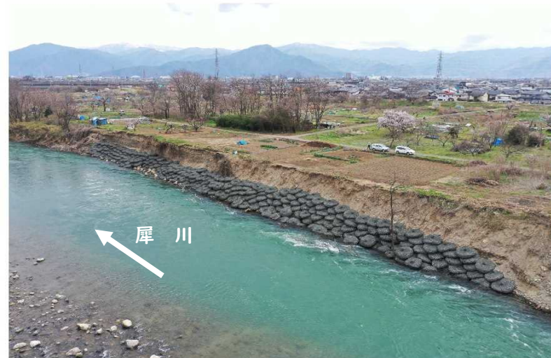
四ツ屋地区河岸応急処理
