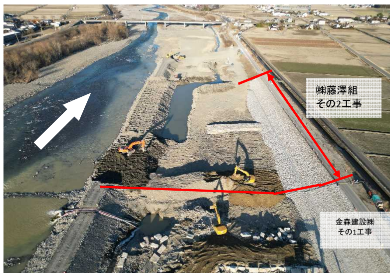
1月30日現場状況撮影
