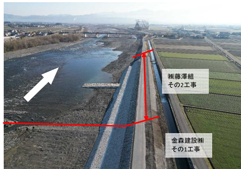
3月20日現場状況撮影
