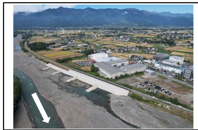
9月末現場状況(令和4年9月29日撮影)
