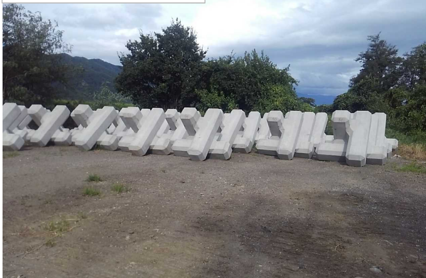
根固めブロック製作ヤード
