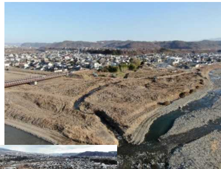
丸子工区 (伐採状況)
