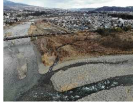
丸子工区 (着手前)
