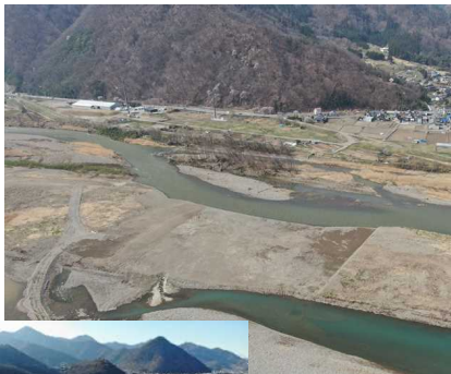
南条工区 (中州掘削完了)
