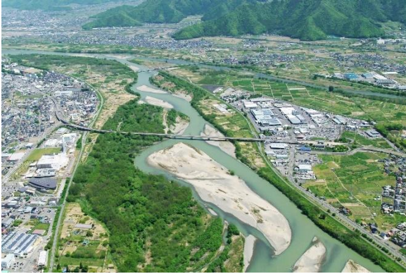
写真-2-7 犀川下流 (勾配≒1/500) R5.5 撮影
