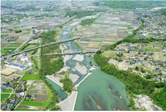
写真-2-5 犀川上流 (勾配≒1/100) R5.5 撮影
