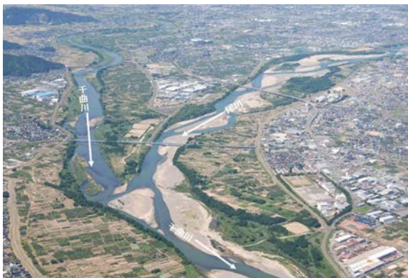
写真-2-7 犀川下流（勾配≒1/500）
