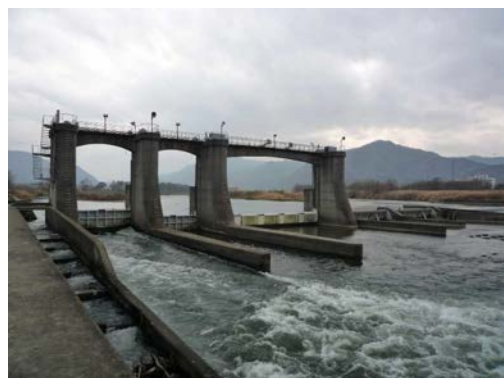
写真-2-9 埴科頭首工（埴科郡土地改良区）
