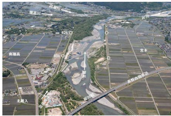
写真-2-6 三川合流点（勾配≒1/300）
