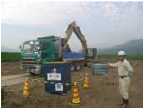
現場内設置状況
