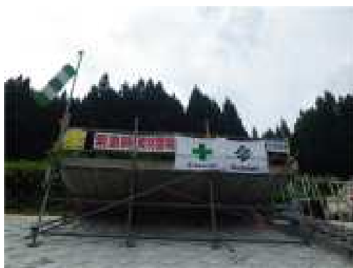
仮設ステージ正面
