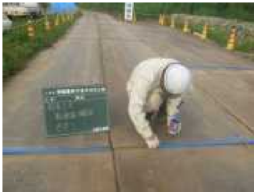
着色作業状況
