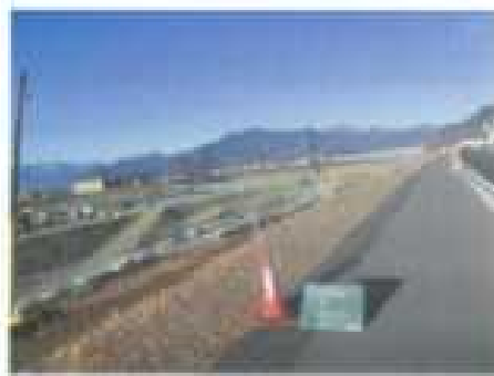
【作業を行っていない時】
